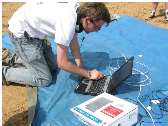
G05002 Mise sous tension de la nacelle
