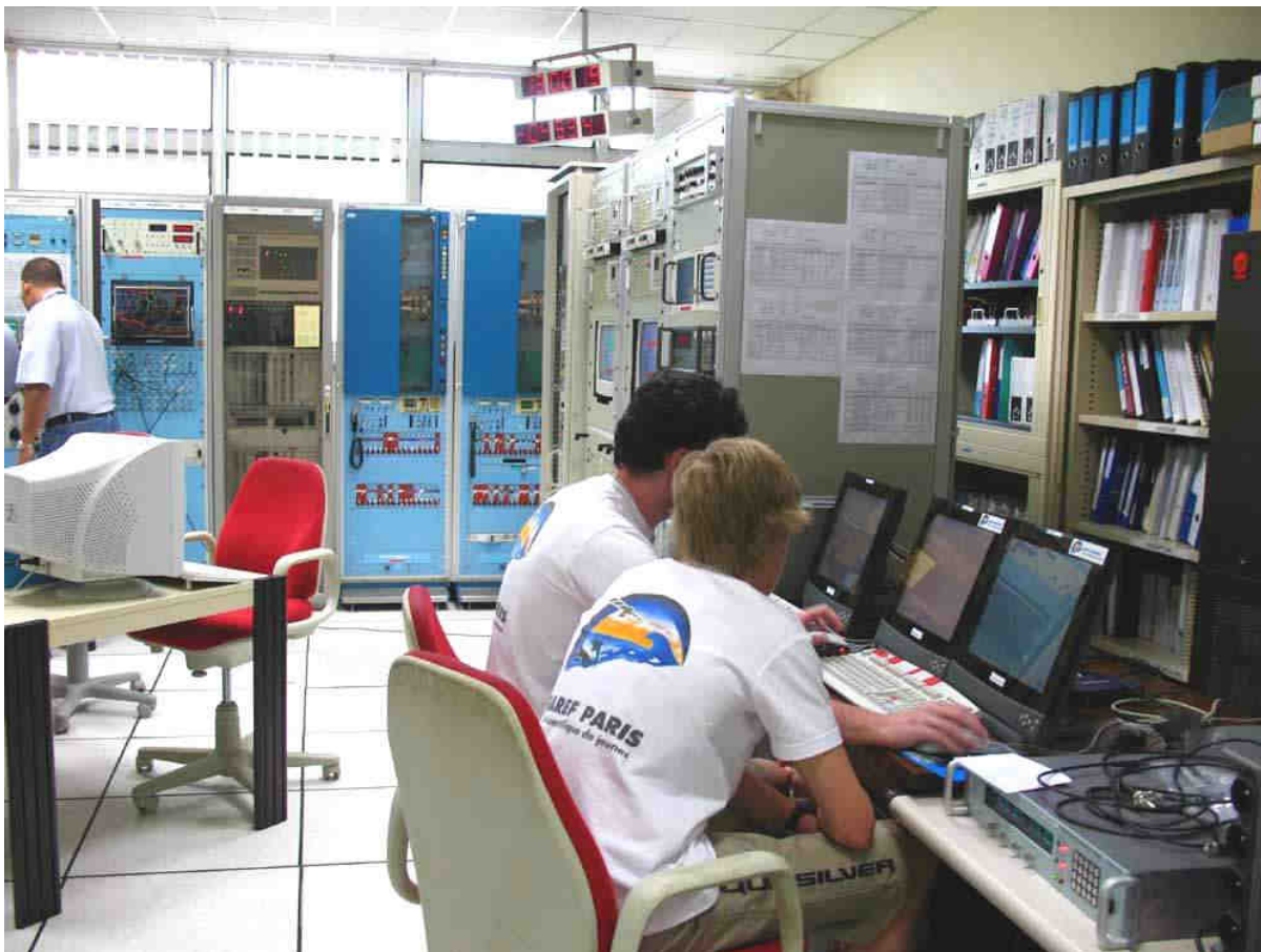
A la station Galliot, le GAREFa installé ses équipements (Décommutateur, PC et écrans) à droite des baies de réceptions comprenant les récepteurs RTID (Photo G07H136. Photo GAREF PARIS)
