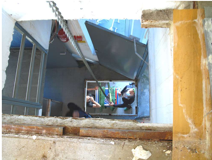
Figure 10 : Montée du matériel de la station de réception trop lourd pour être porté à la main, par un treuil opéré par l'équipe technique de l'Observatoire que l'on remercie vivement.
